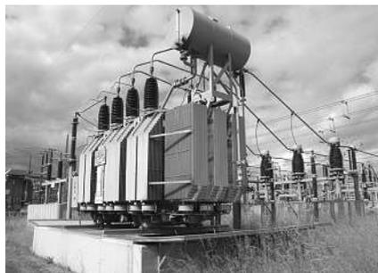
Bild 1.6 Leistungstransformator mit Freiluftschaltanlage
