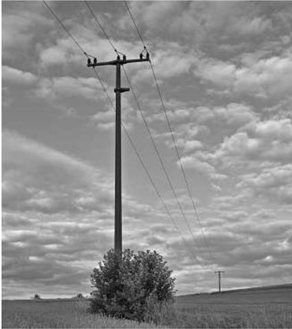
Bild 1.7 Mittelspannungs-Freileitung (Netzebene 5)
