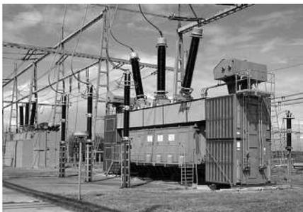
Bild 1.5 Transformator 380/110 kV
