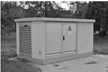
Bild 1.9 Ortsnetzstation (Netzebene 6)
