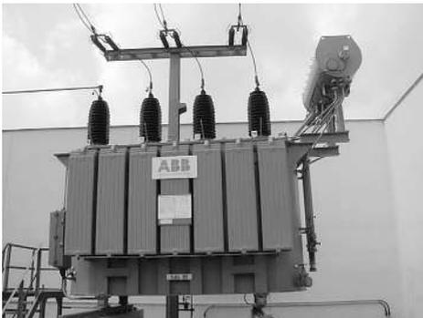
Bild 2.1 Leistungstransformator 110/10 kV in einem Umspannwerk
