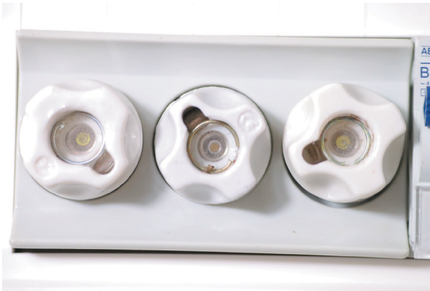
Bild 2.6 Sicherheitssockel mit Schraubkappe
